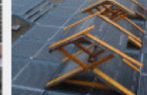
Rohbau einer Ausstellung
