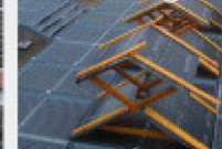
Rohbau einer Ausstellung
